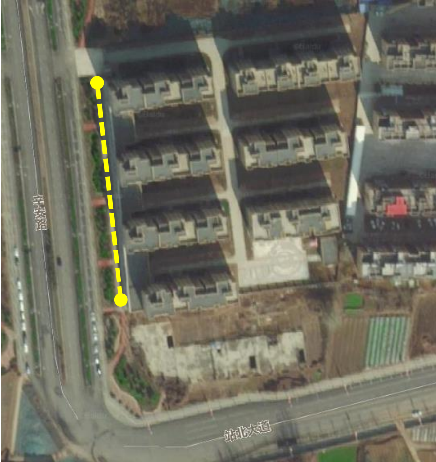
袁小屯安置社区（站北大道北、辛安路东侧）
