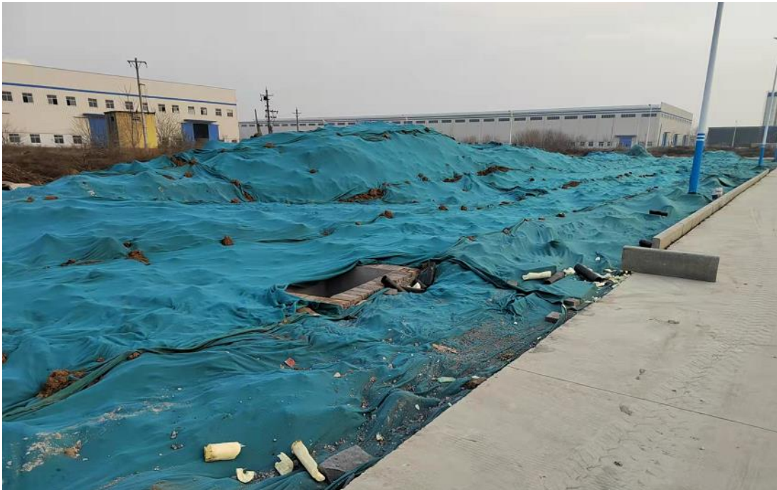
照片 3.5-1 比亚迪云轨在建区域土工布苫盖
