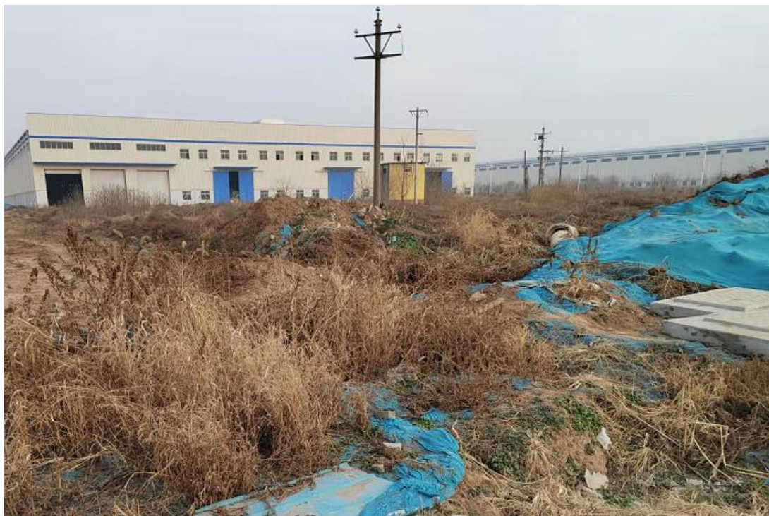
照片 3.5-2 比亚迪云轨在建区域土工布苫盖
