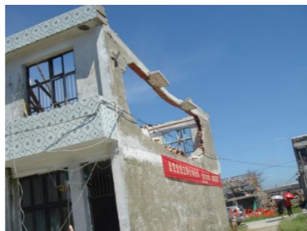
掀翻屋盖、破坏墙体、造成局部倒塌
