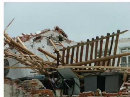
掀翻屋盖、破坏墙体、造成局部倒塌
