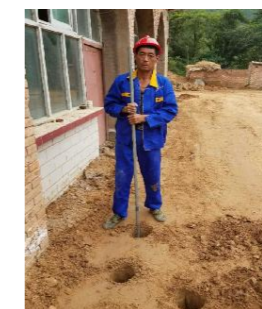
处理宽度为基础外延2m左右
