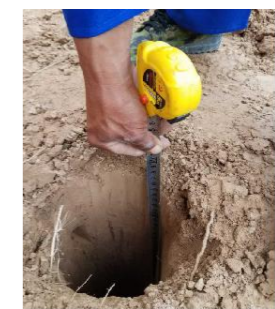
深度1.5m左右，并不小于基础埋深，孔径300mm
