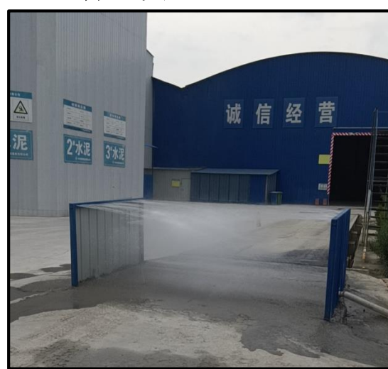
车辆冲洗装置
