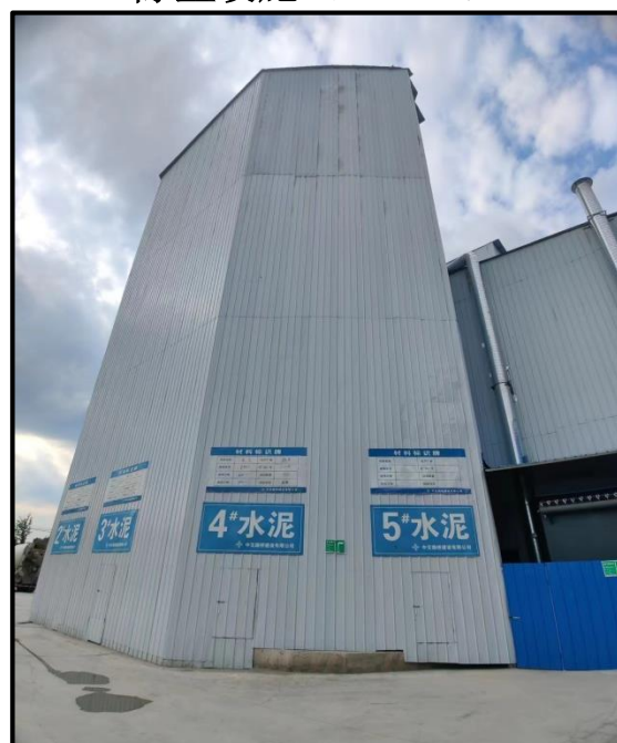
除尘设施 (DA004)
