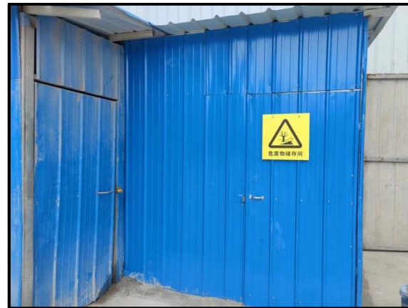
现有危废暂存间
