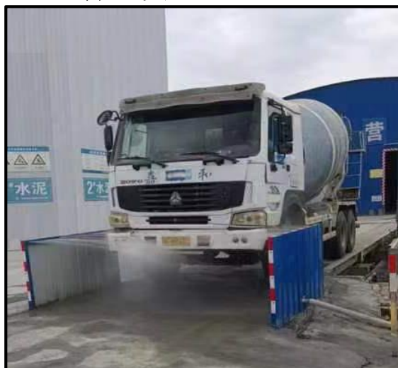
车辆冲洗装置
