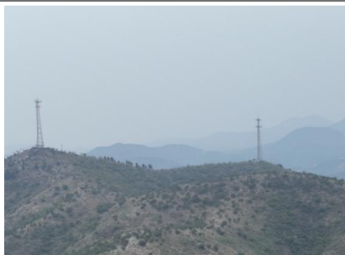
矿区外西南侧 300 米处高压线
