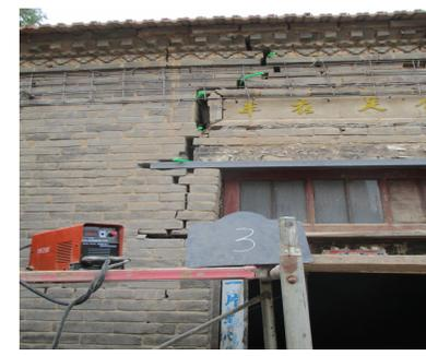
裂缝灌浆埋管
