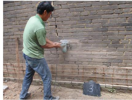
裂缝镶嵌钢筋开槽
