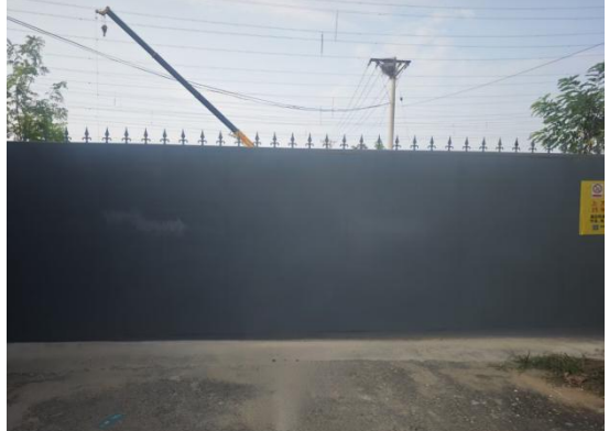
2-9、魁元府村在建厂区
