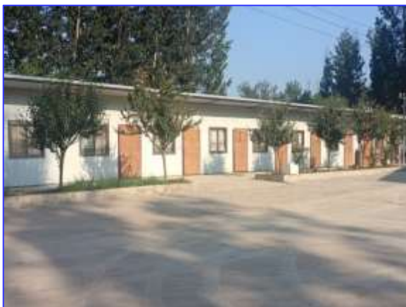
厂区东北侧闲置办公室
