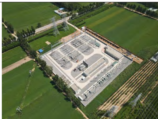
阮咸 220kV 变电站周边自然环境
