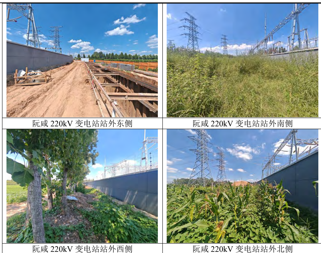
图 4 工程站内设施和站外区域环境现状
