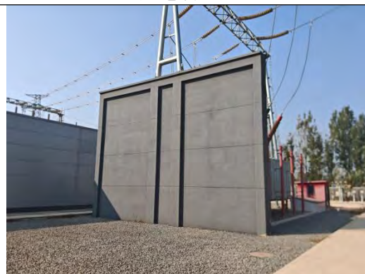
拟建 2#主变压器建设场地
