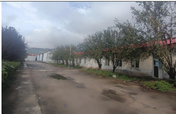
租赁厂房西侧现状
