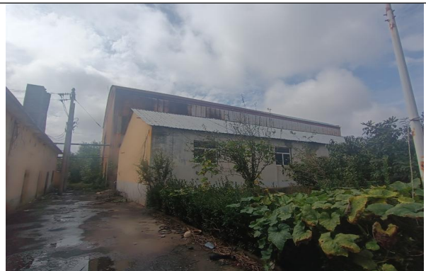
租赁厂房南侧现状
