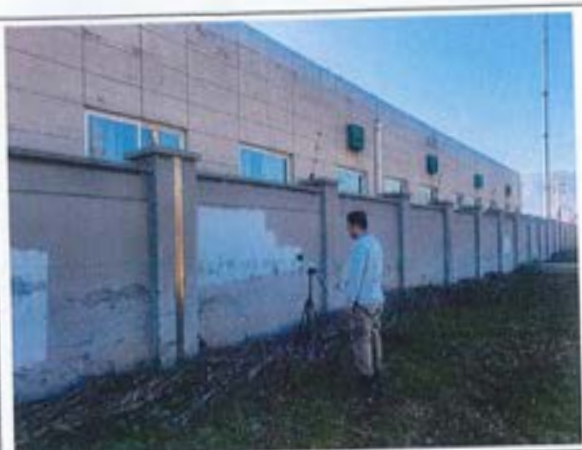
变电站北侧厂界 (2#) 昼间噪声检测照片
