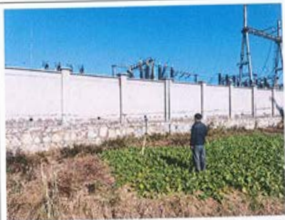
变电站南侧厂界 (5#) 电磁检测照片
