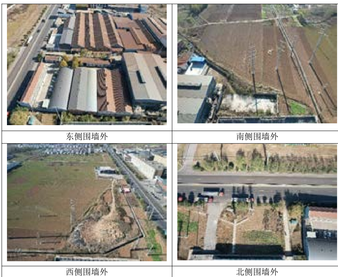
图 2-2 申家泊 110kV 变电站四周现状照片
