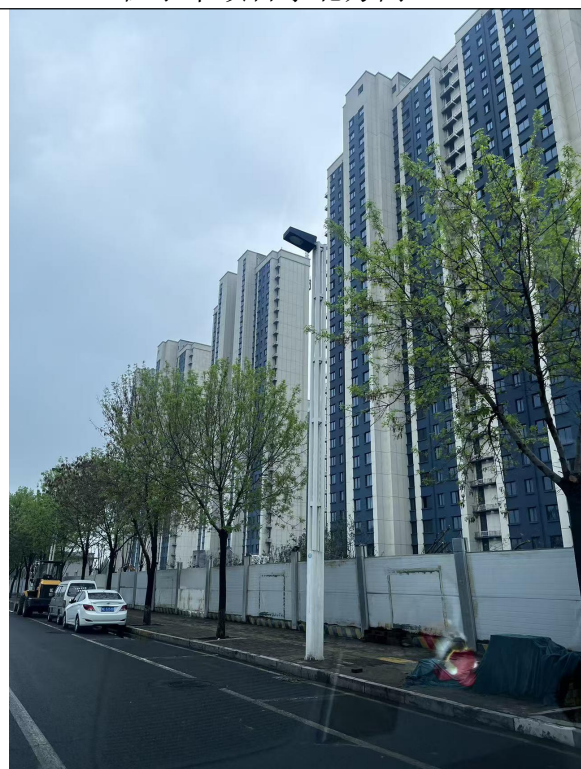
中国一冶安阳高新区棚改安置房 (一期工程, 位于本项目西南 530m 处)
