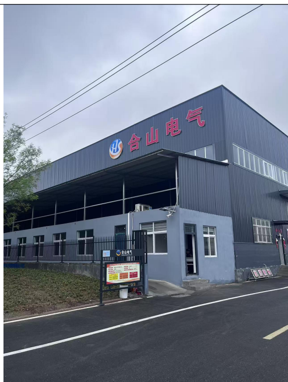
河南合山电气有限公司 (位于本项目东侧 15m)
