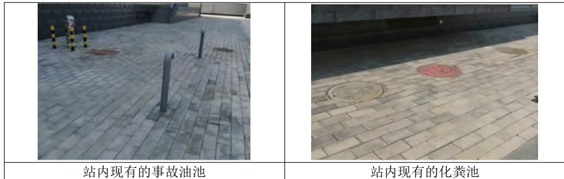
图 2 晟观 220kV 变电站站内环保设施及措施现状
