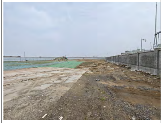
梦泽 220kV 变电站站外北侧
