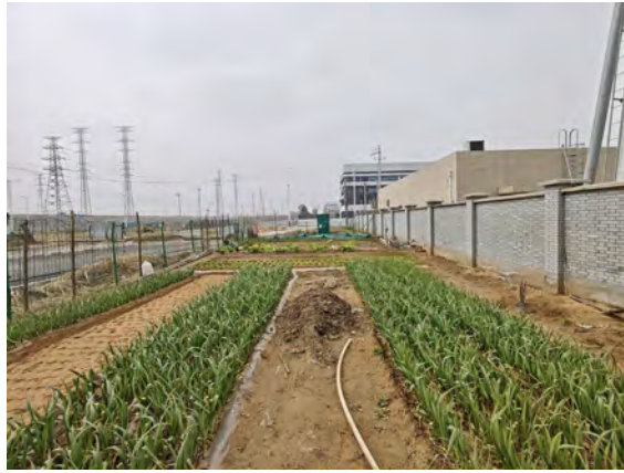
梦泽 220kV 变电站站外南侧
