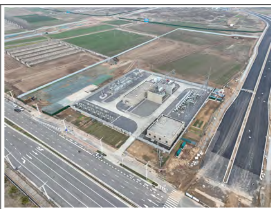
变电站周边自然环境状况
