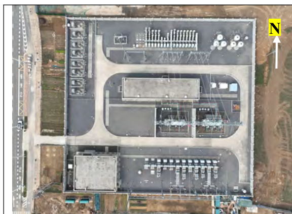
梦泽 220kV 变电站鸟瞰图
