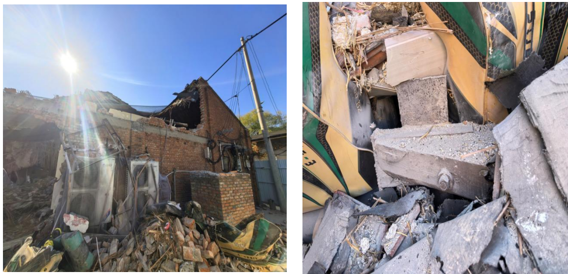
图 4 现场勘验情况图
