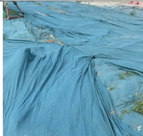
裸露地面苫盖
