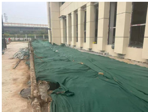
裸露地面苫盖
