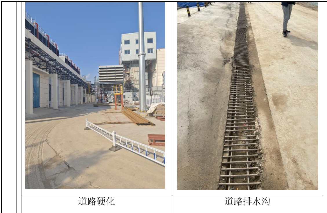
图 9 施工现场照片
