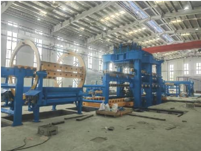
在建项目静压线
