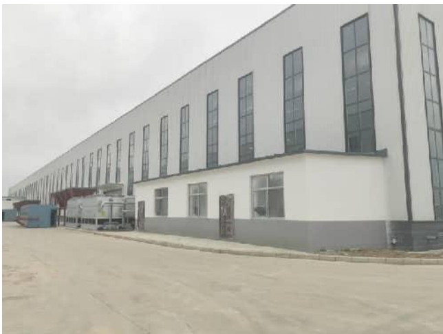
在建项目车间外北侧
