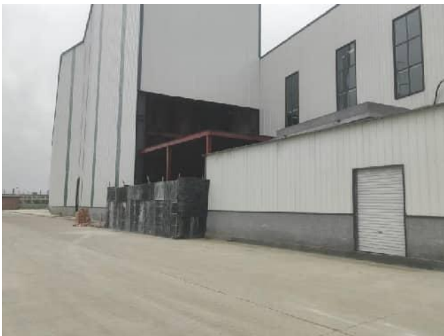
在建项目砂处理
