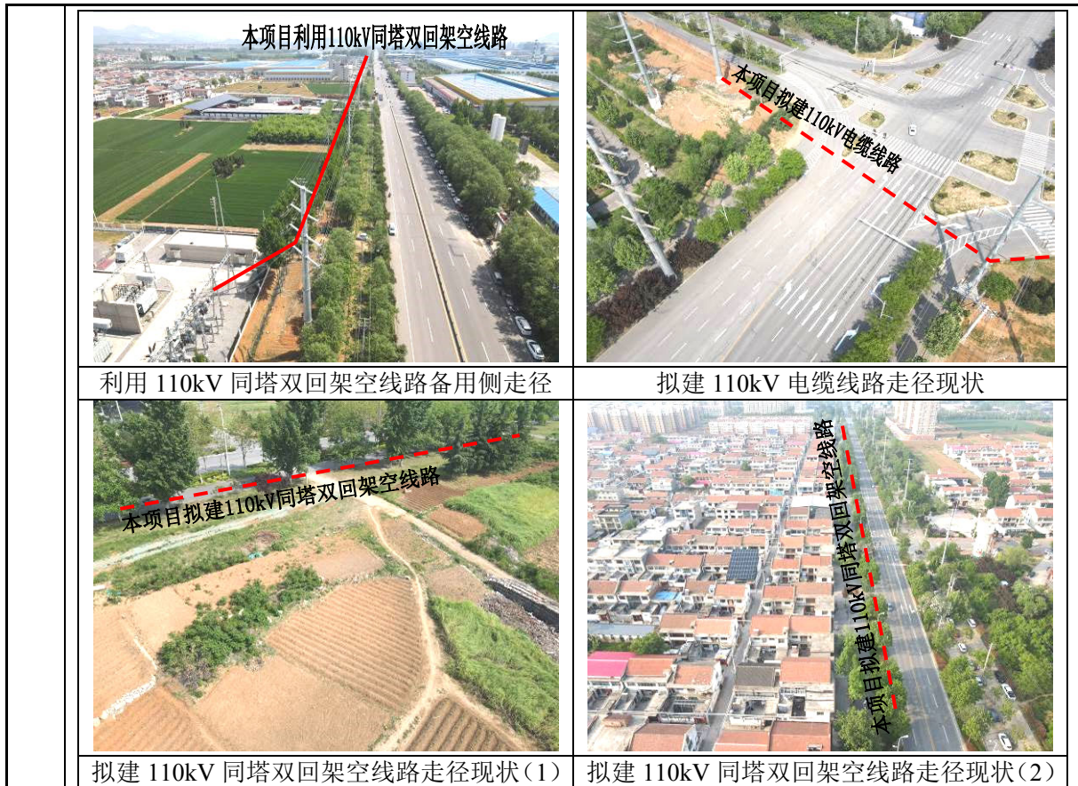
图 3-1 本项目输电线路路径现状
