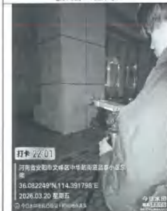
昌泰小区距离最近一栋楼1层（夜间）
