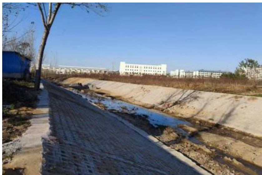
图 2.3-7 寺下沈村中桥桥位处现状
