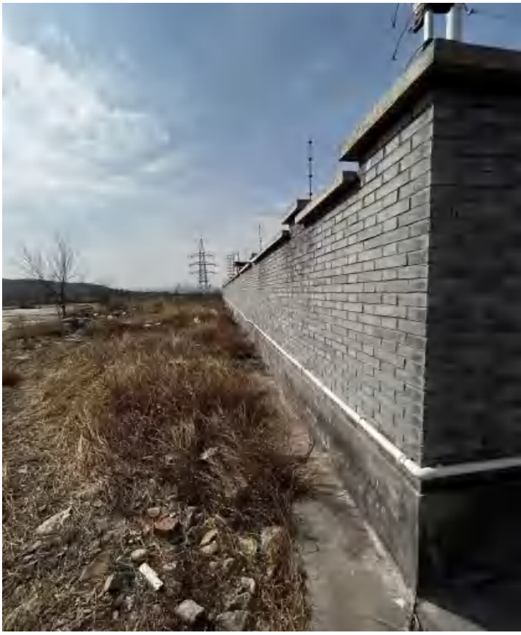
110kV 升压站东厂界
