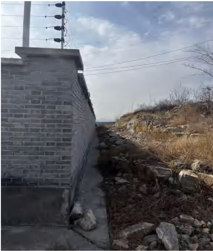
110kV 升压站西厂界
