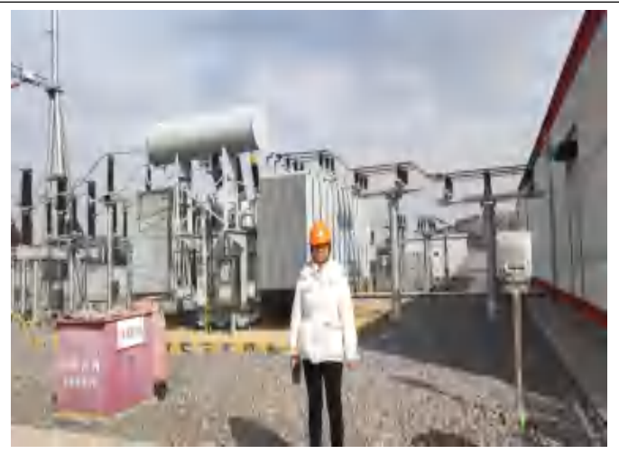
工程师勘察现场
