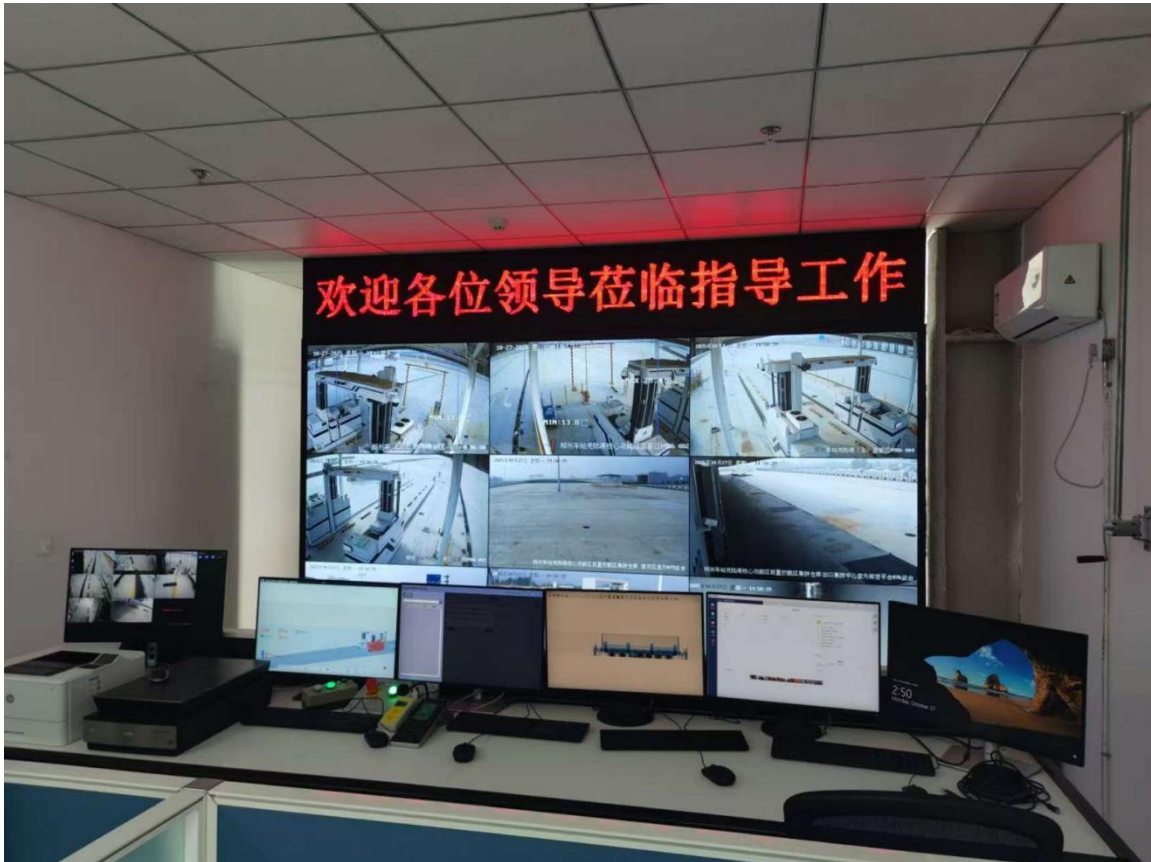
图 10.9 操作室操作及视频监控（画面为现有装置区域）
