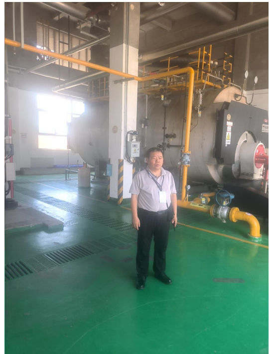
工程师现场踏勘照片
