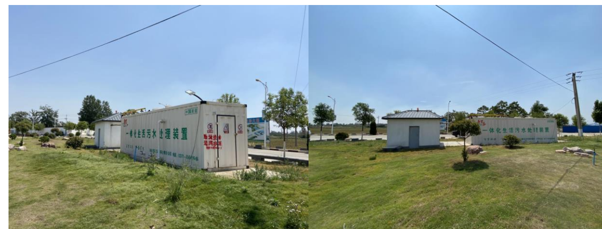
图 2-14 大堰村污水处理设施
