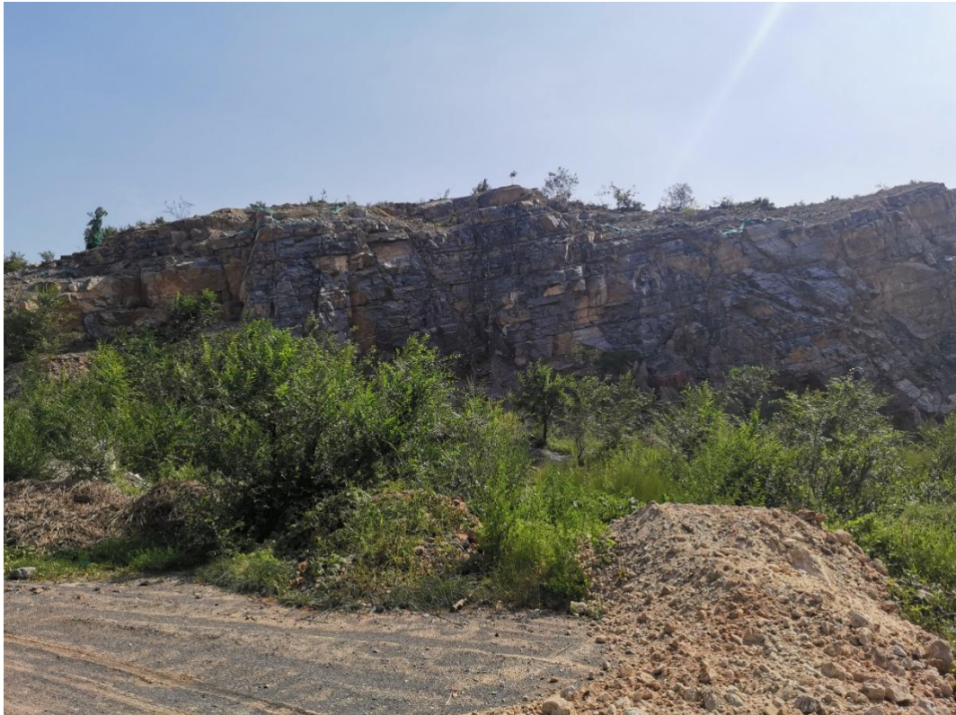
照片 3-1 潜在崩塌（危岩体）
