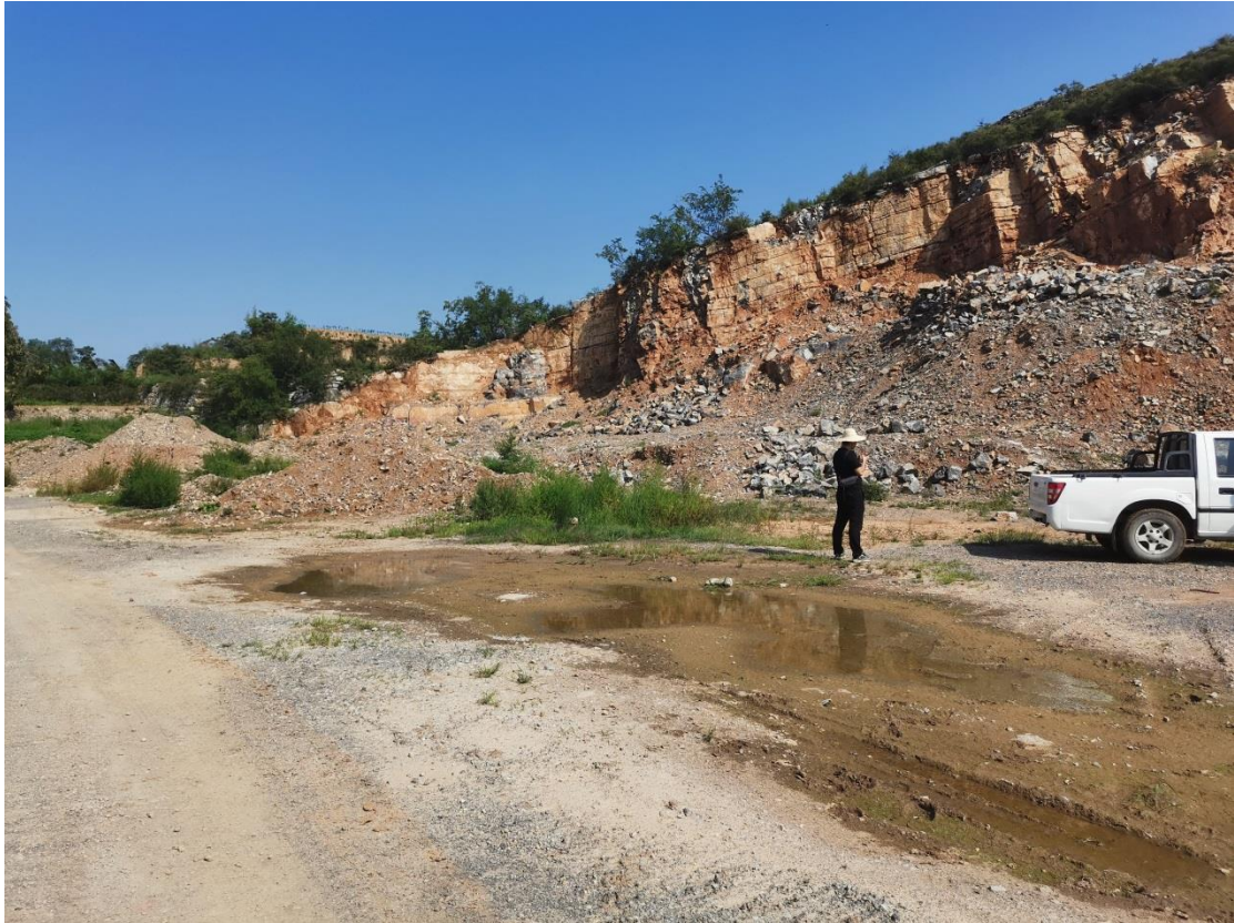
照片 5-3 不稳定斜坡
