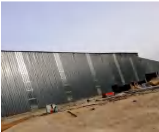
厂区东侧安阳市德星冶金耐材有限公司
