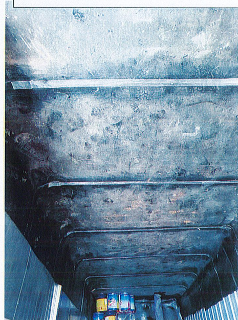
危废间地面进一步防渗
