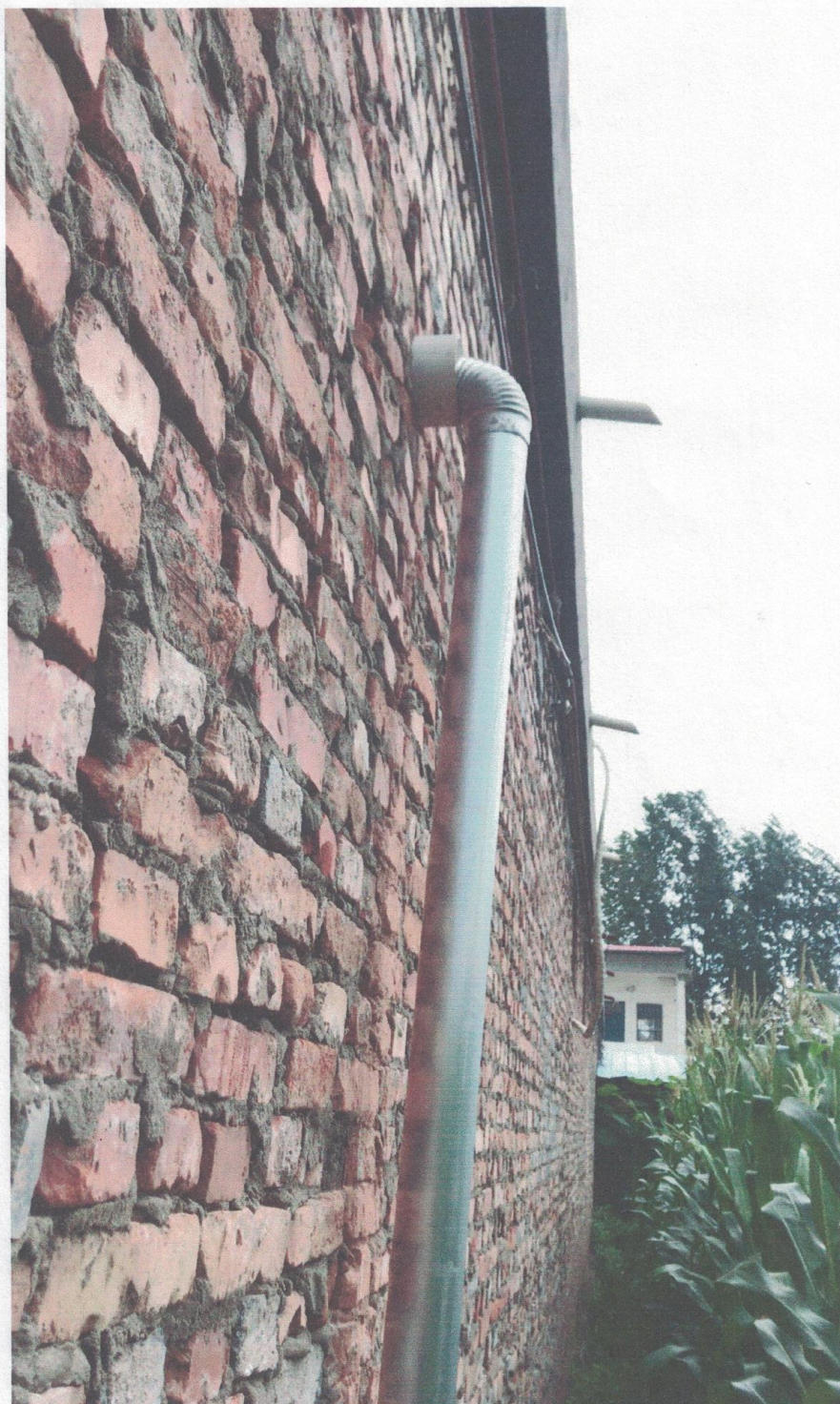
附图 4 熬制工序水蒸气冷凝管整改图片
