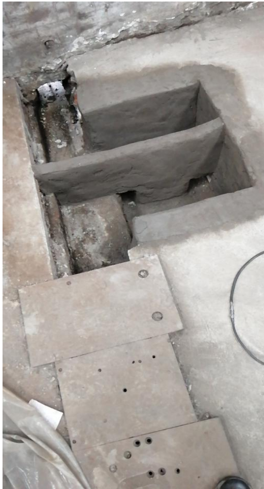
附图 10 隔油池整改照片
