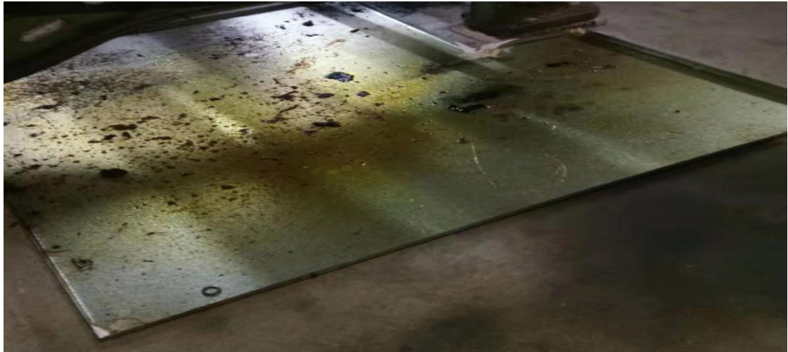
附图 9 地面集油托盘整改照片
