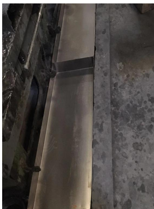
附图 5 围堰和废机油托盘整改照片
