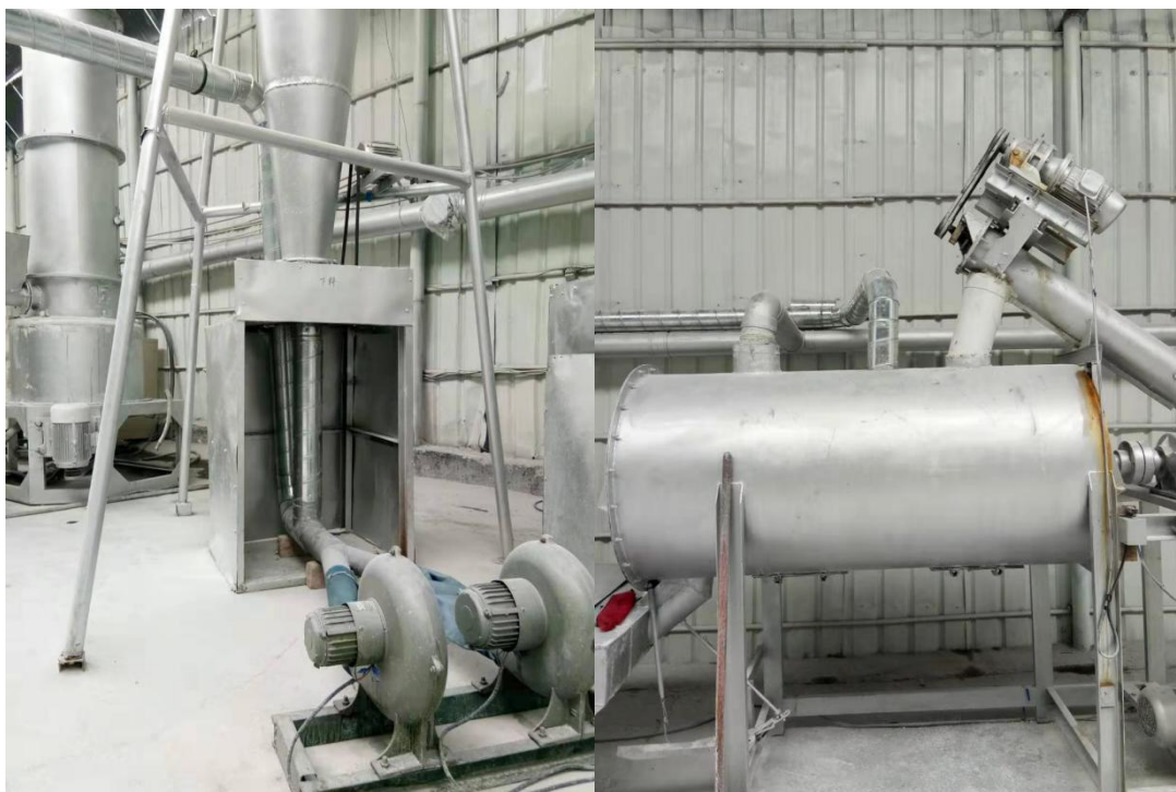
附图八 东厂区物料密闭输送设备整改后照片
