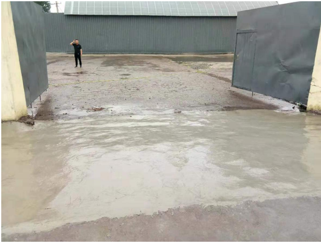
附图九 东厂区大门口路面硬化整改后照片
