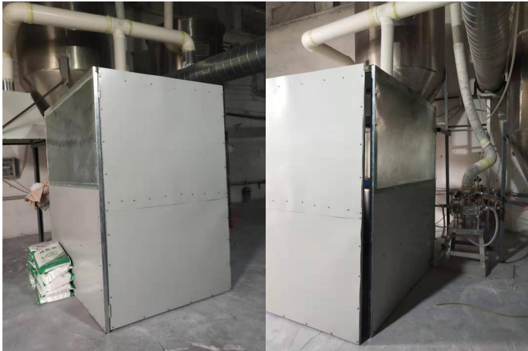
附图六 西厂区进料口整改后密闭间照片
