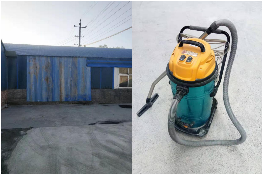
附图十 车间封闭、车间地面清扫设备整改后照片
