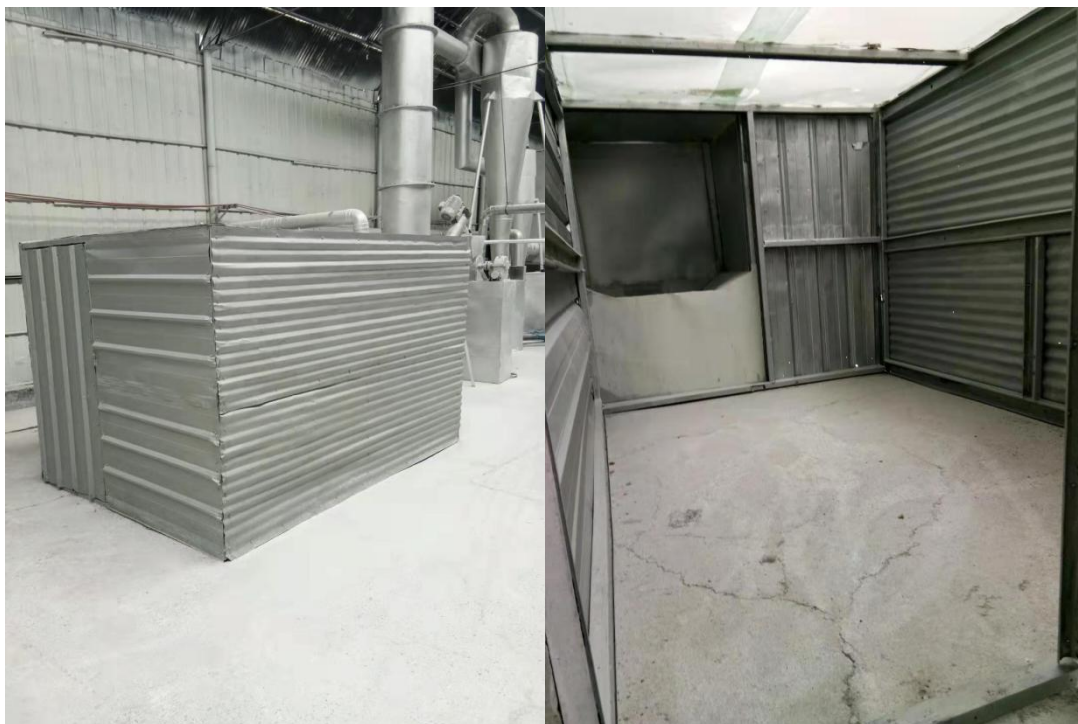
附图七 东厂区进料口整改后密闭间照片
