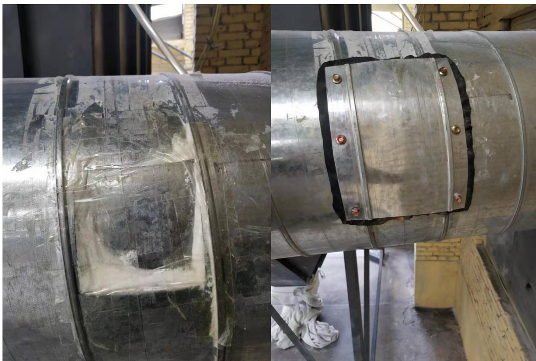
附图五 采样孔规范设置整改前后照片
