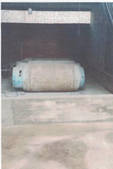
附图 9 二甲醚存放区围堰整改照片
