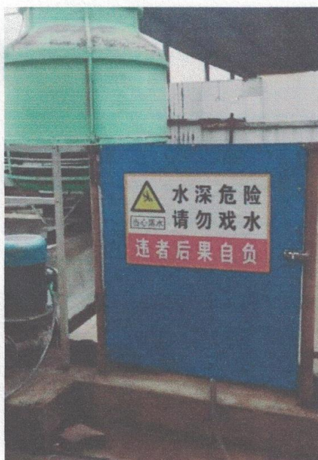
附图 10 事故应急池整改照片
