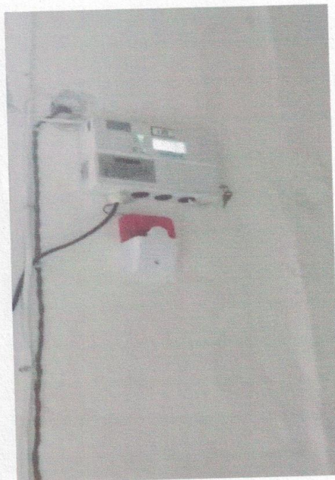
附图 4 二甲醚监控探头、室内报警器整改照片
