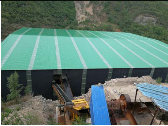
项目建设生产车间
