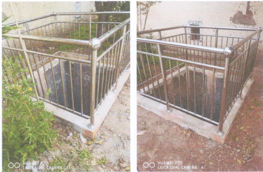
附图 8 消防事故池整改照片
