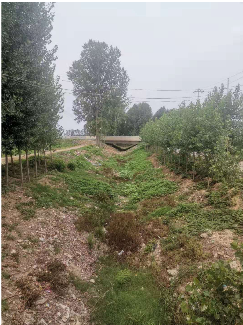
图 4-2 监测单位拍摄的蒋沟河刘村断面现场情况图 2
