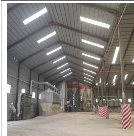
项目混凝土生产车间
