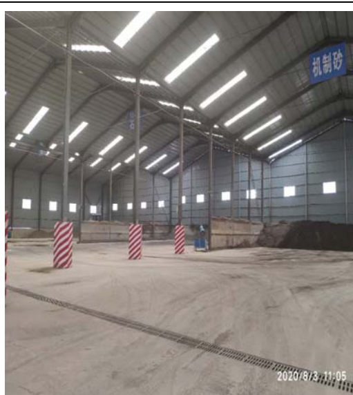
项目混凝土料库
