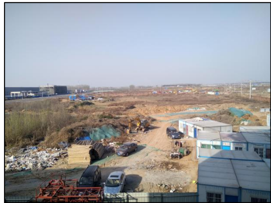
东北侧园区待建设现状
