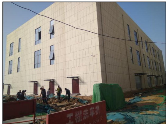
西侧在建的河南通嘉质检技术服务有限公司
