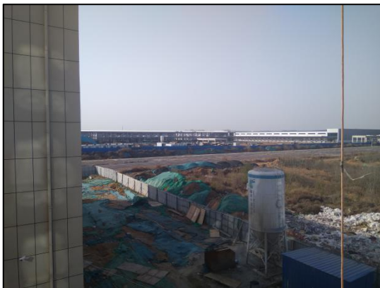
西北侧在建仓储项目现状
