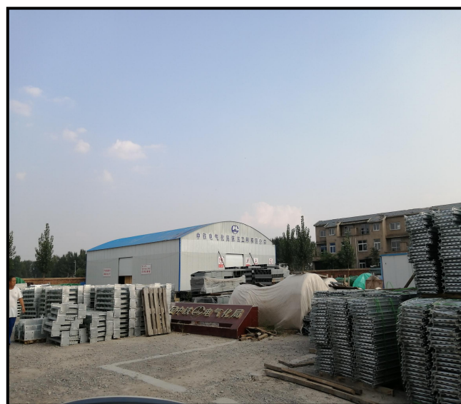
项目东南中铁电气化局料场
