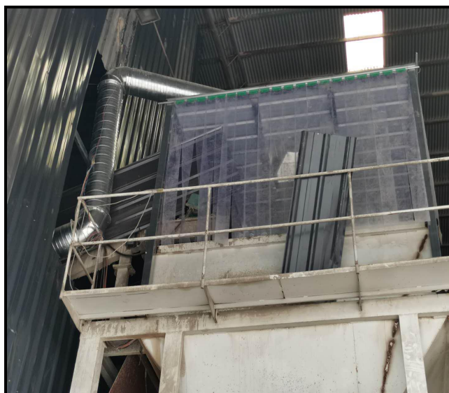
水稳线皮带输送粉尘收集措施 2
