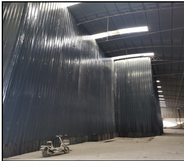
水泥稳定砂石生产线封闭搅拌楼
