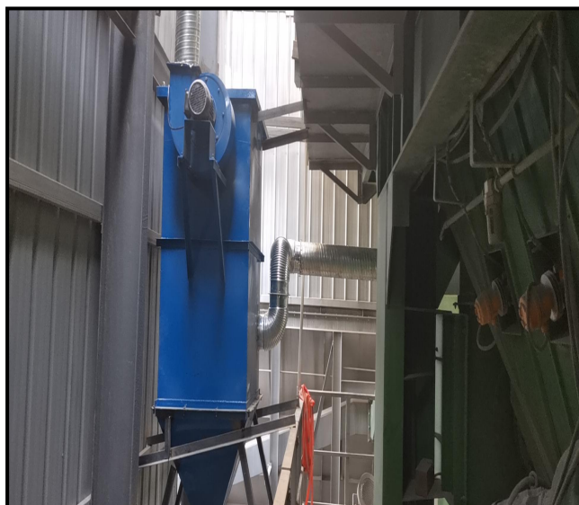
沥青混凝土生产线筛分工序除尘器
