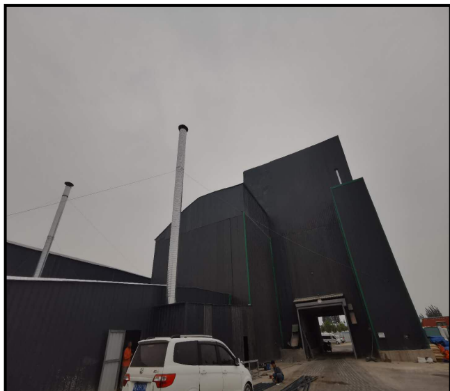
沥青混凝土生产线排气筒
