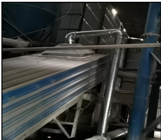
水稳线皮带输送粉尘收集措施 1
