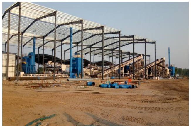
项目厂区现状
