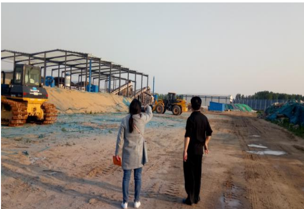
项目厂区现状
