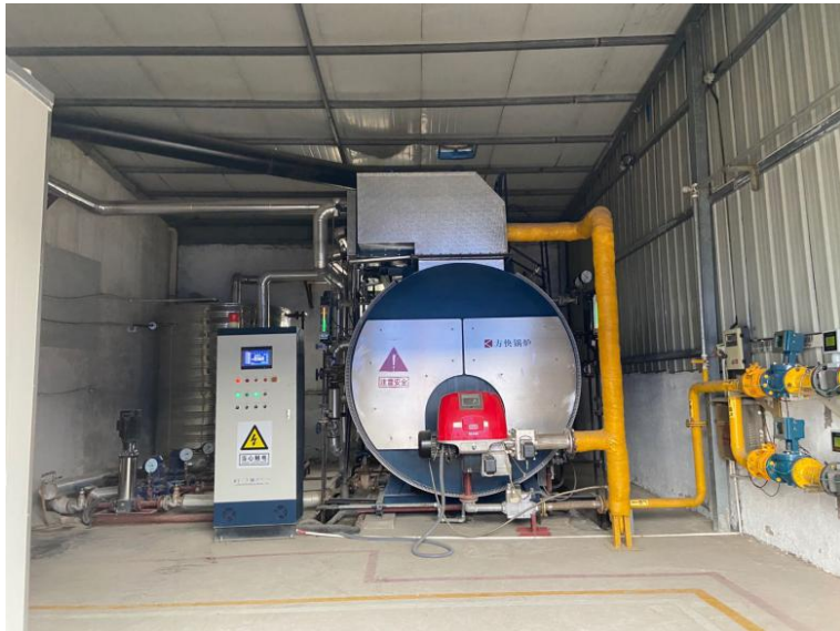
图 3 项目现状锅炉房
