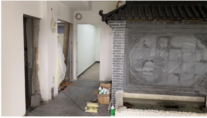
6 层（河南中泰房屋安全鉴定有限公司）
