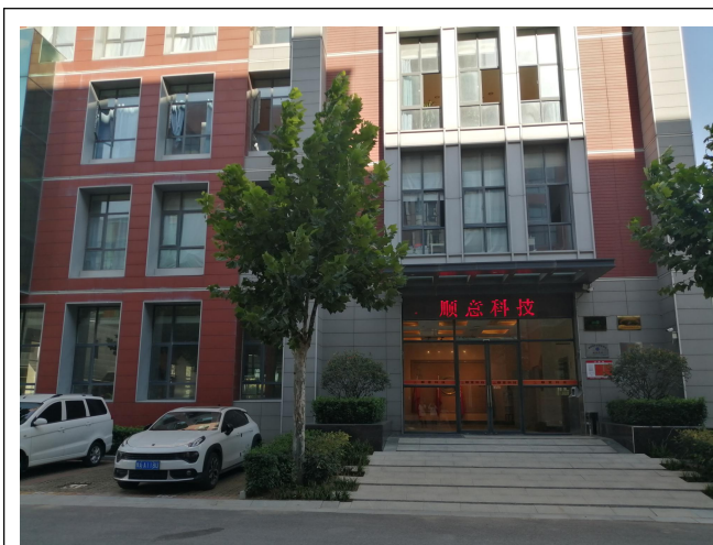
项目东侧 B1-2 号楼
