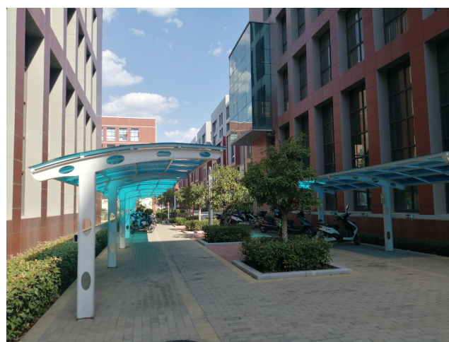
项目南侧停车棚
