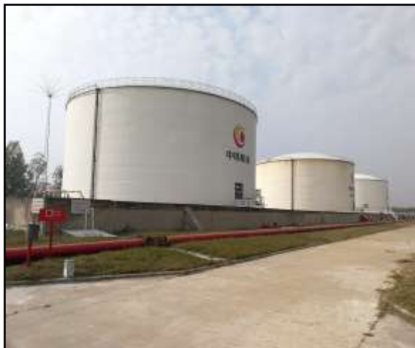
现有工程罐区
