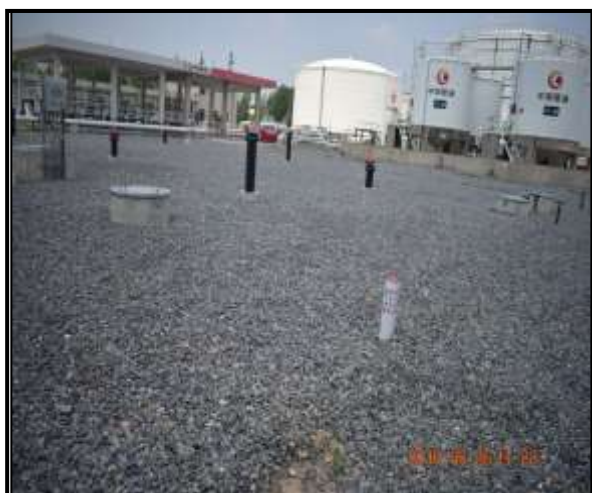
现有隔油事故水池
