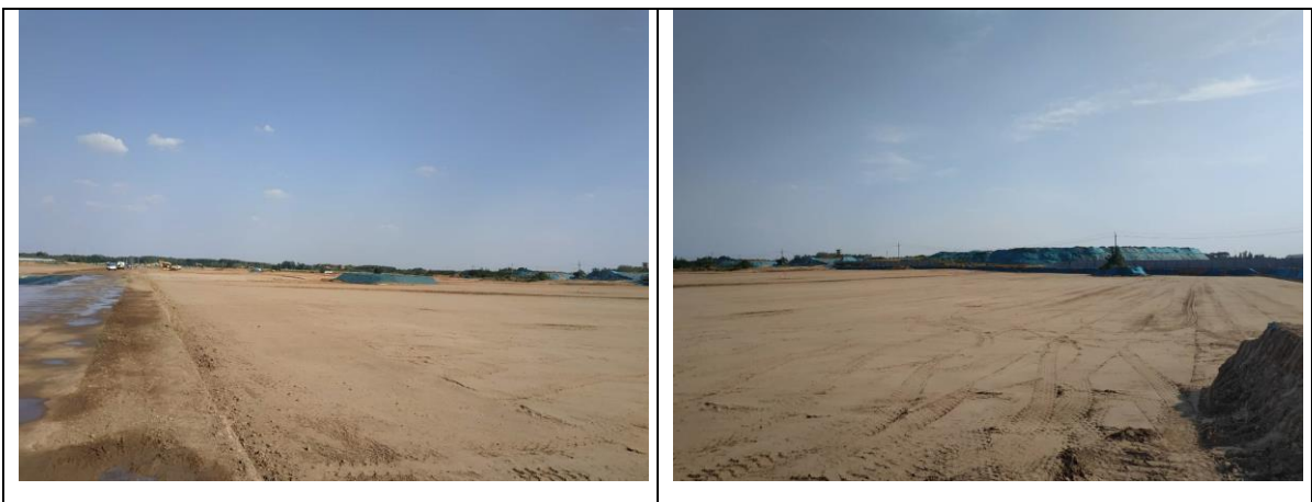
图 1-1 场监雷达站址现状照片
