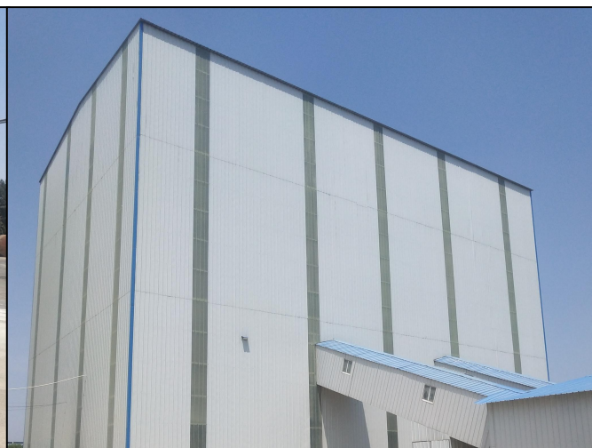
现有工程搅拌楼
