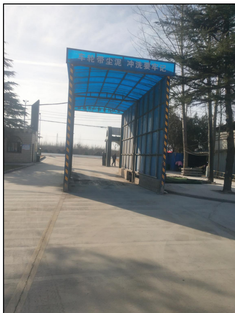
厂区门口车辆清洗装置
