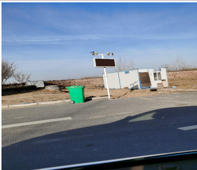
厂区扬尘监控系统
