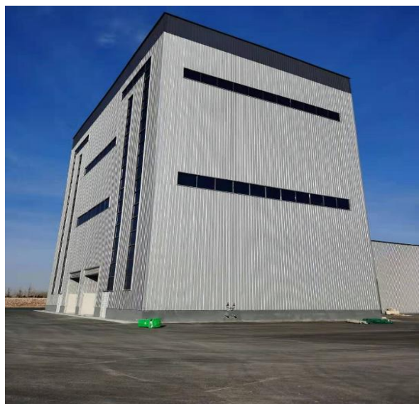
项目混凝土搅拌楼
