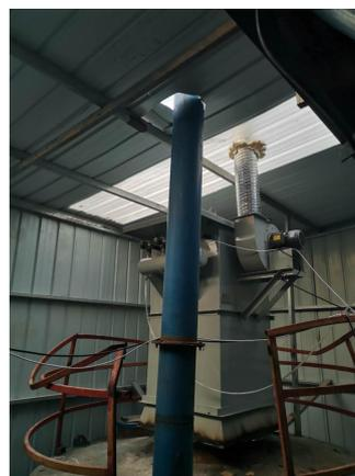
筒仓仓顶脉冲袋式除尘器
