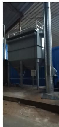
沥青混凝土生产线上料的除尘器
