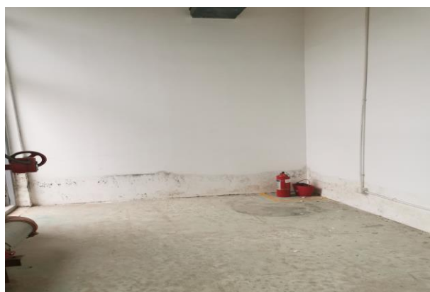
1F107 危废暂存间
