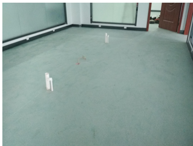
项目厂房现状
